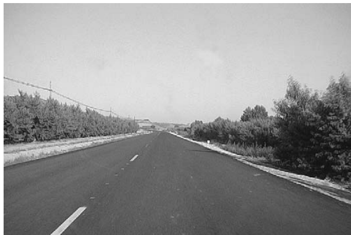
Un dels trams ja acabats de la carretera de Saidí
