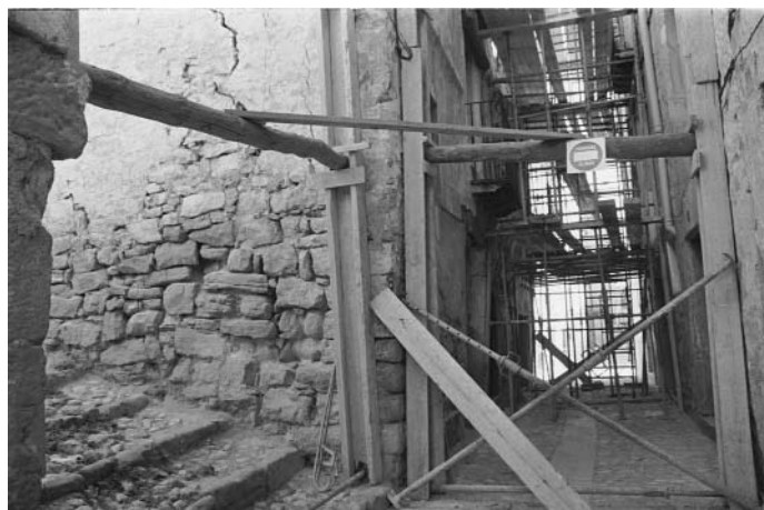
El carrer de Sant Roc porta dos anys tallat per les cases apuntalades
