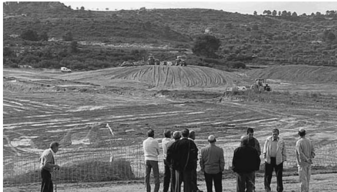
Una colla de veïns observa les obres de moviment de terres per a construir la bassa de la Trapa
