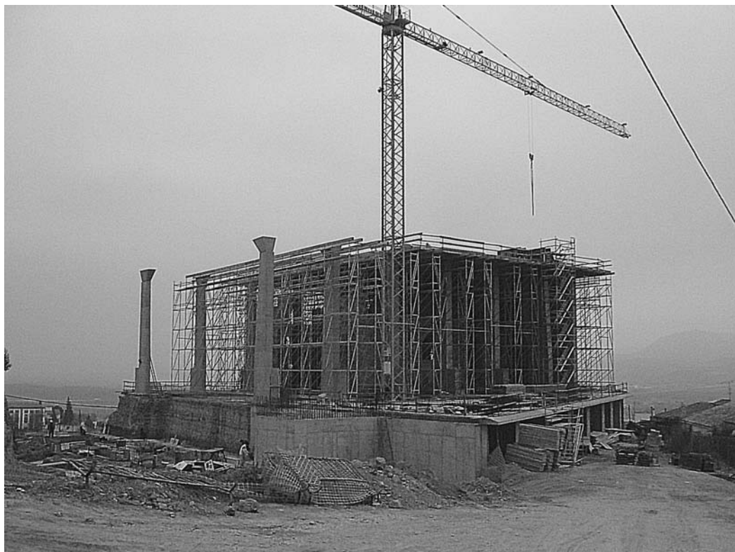
Obres del Castell de Fraga al setembre de 2004
