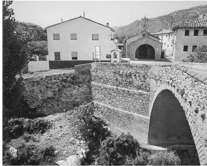
Pont i ermita de Santa Anna a Beseit
